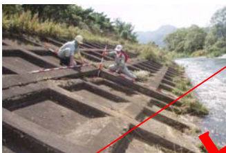
護岸損傷状況の調査
