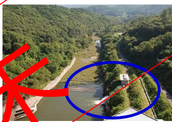
田瀬ダムにおける維持流量の放流
