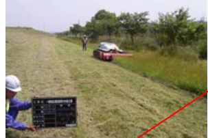
堤防除草の状況(左:ハンドガイド式除草機械 右:大型機械の遠隔操作)
