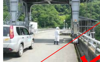
ダムの堤体巡視
