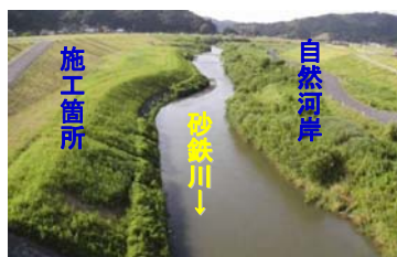
多自然川づくり事例(砂鉄川右岸2.0k付近)
