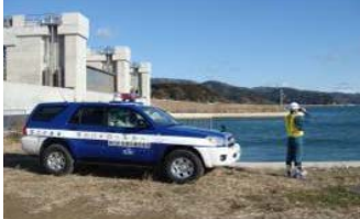
河川巡視の状況
