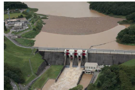
四十四田ダムの流木(平成19年9月洪水)
