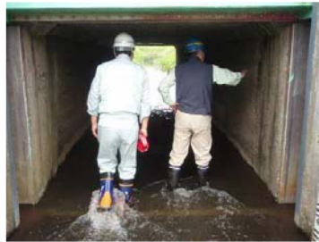
樋管函内の点検状況
