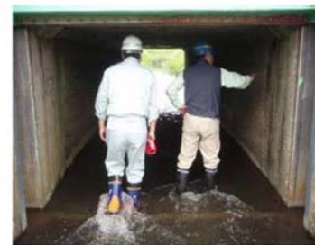
樋管函内の点検状況
