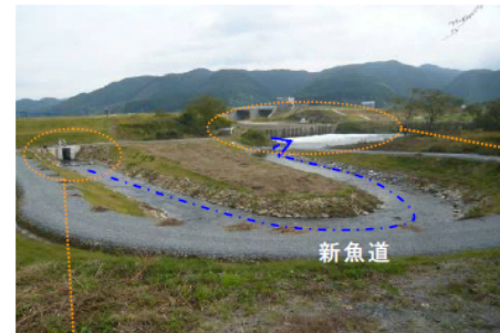
魚道の改築（新魚道）
