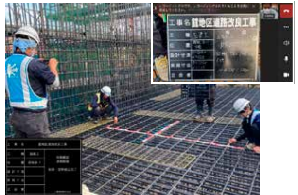
遠隔臨場による鉄筋出来形測定
