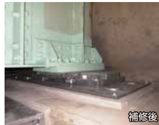
橋梁補修(主桁補修工、支承取替工)
