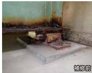
橋梁補修(主桁補修工、支承取替工)
