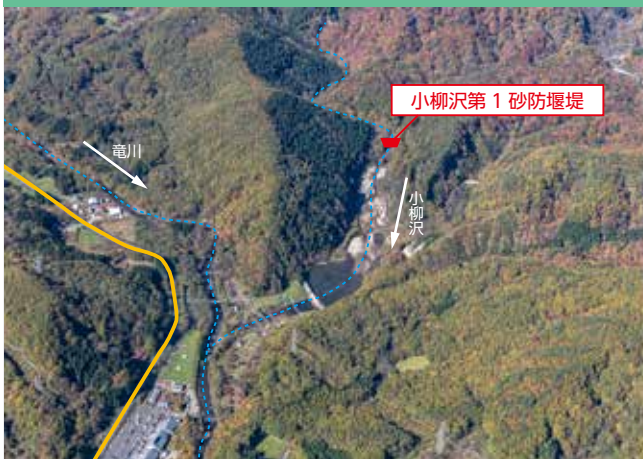
②小柳第1砂防堰堤 R6実施内容：砂防堰堤工
