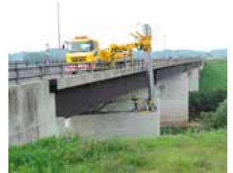
橋梁定期点検
