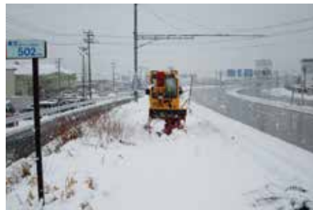
歩道除雪(機械)
