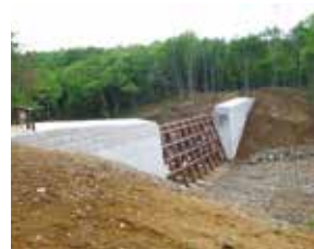
土石流発生前（H24年6月）
