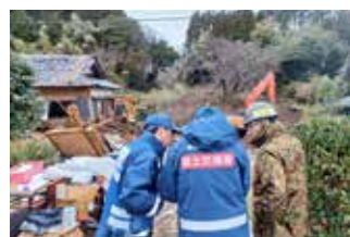
TEC-FORCE活動状況 (令和6年1月能登半島地震 石川県珠洲市)
