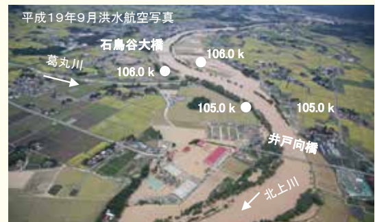
整備前(平成19年9月洪水)
