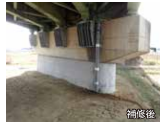
橋梁耐震補強 (横変位拘束構造)
