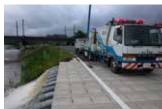
災害対策機械 排水ポンプ車による内水排除 (令和5年7月豪雨 秋田県大仙市)
