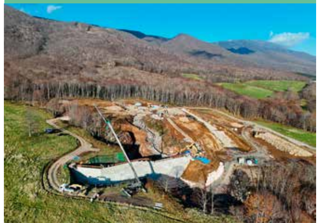
①うさぎ平西沢砂防堰堤 R6実施内容：砂防堰堤工
