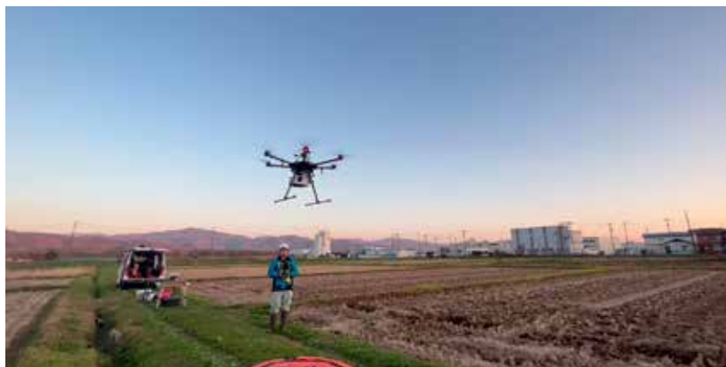
UAVによる路線測量(盛岡南道路)
