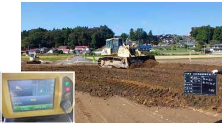
ICT建設機械による盛土施工
