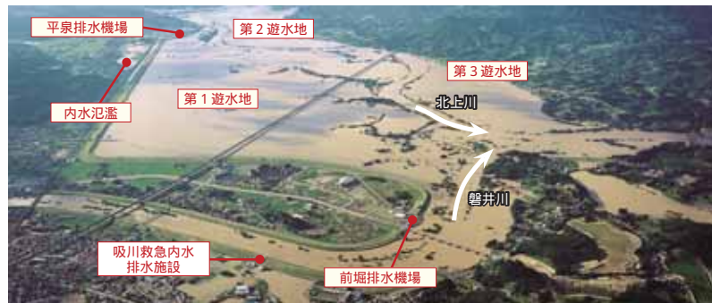
一閑遊水地全景（平成14年7月撮影）
