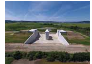
大林水門本体(平成28年8月撮影)
