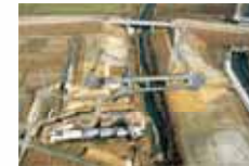
平泉町道一筋橋
