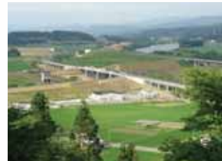
JR東北本線衣川鉄道橋
