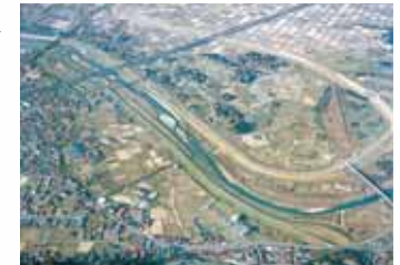
前堀地区第二次暫定盛土完成
