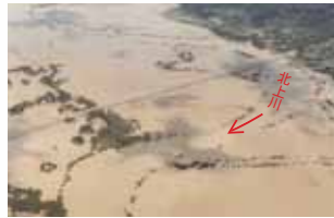
柵ノ瀬橋より第2遊水地付近
