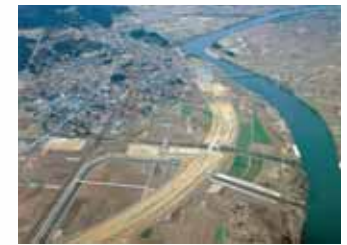
平泉排水樋門完成
