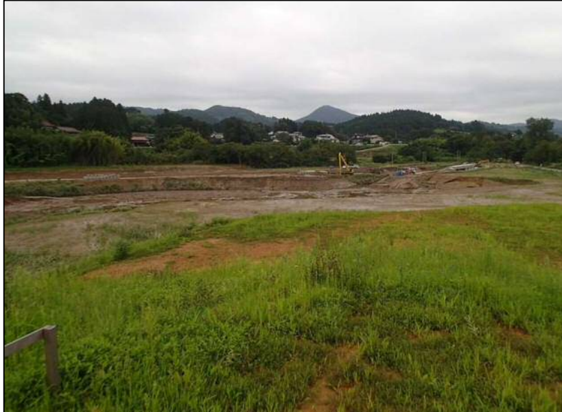
工事写真②
