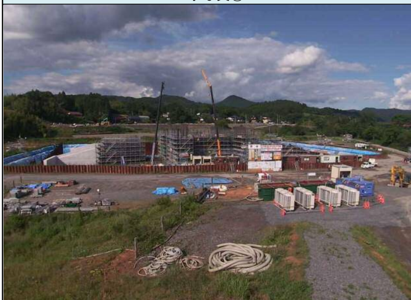
工事写真②
