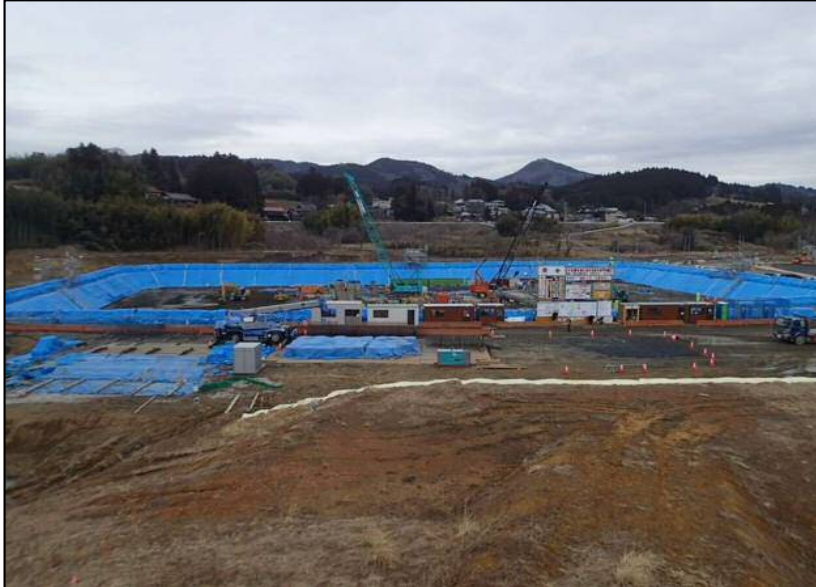
工事写真②
