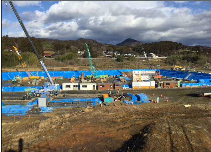
工事写真②
