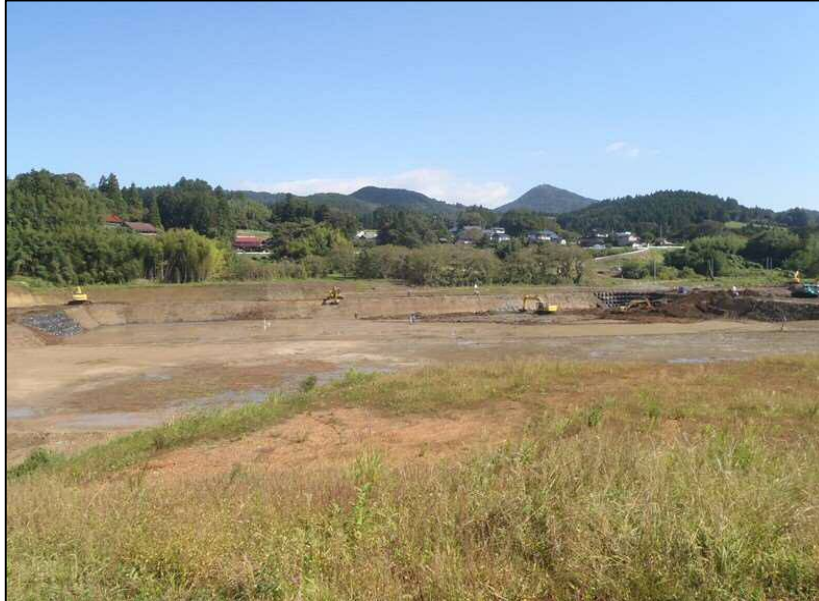
工事写真②
