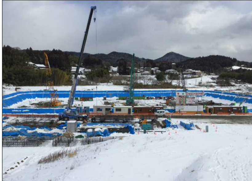
工事写真②
