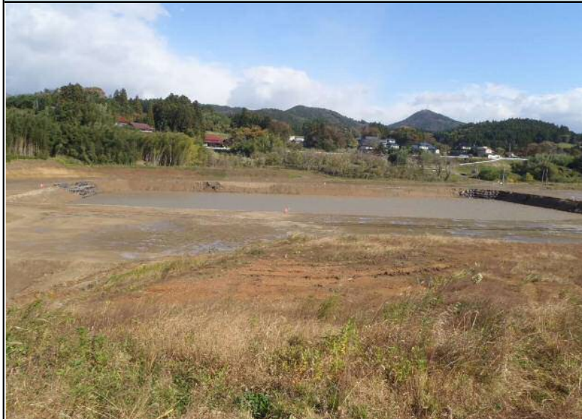
工事写真②
