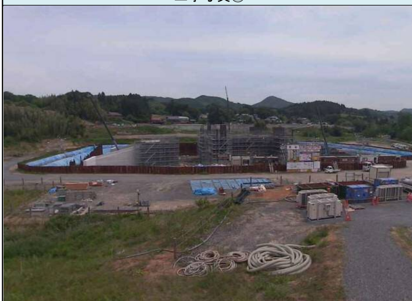
工事写真②
