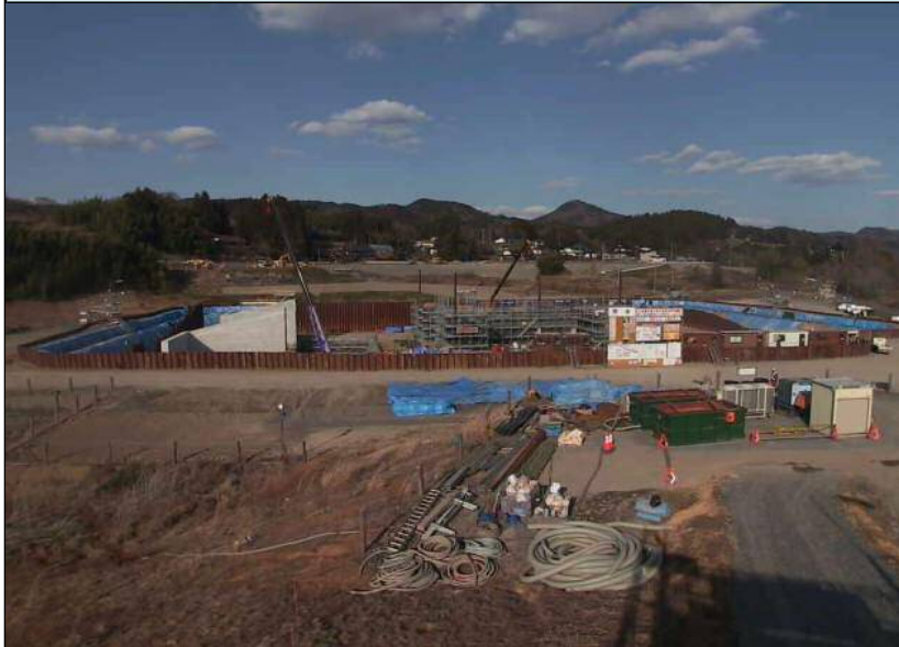
工事写真②
