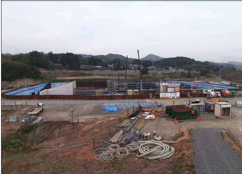
工事写真②
