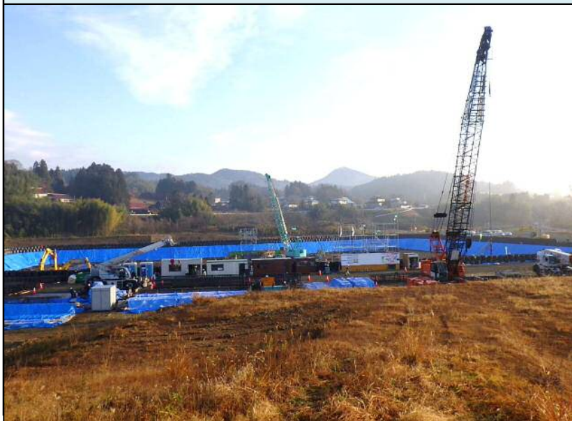
工事写真②
