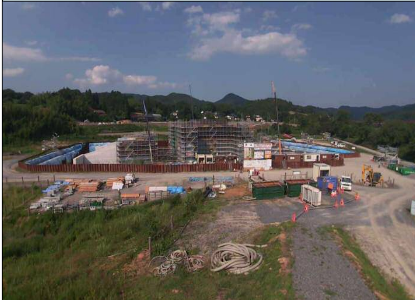
工事写真②
