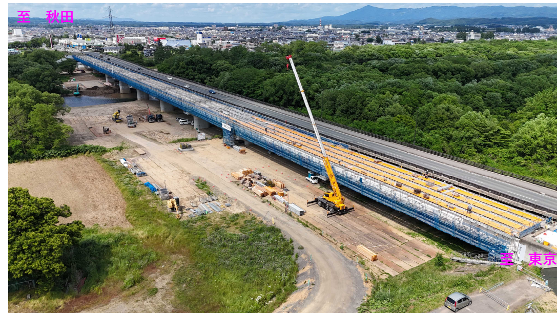
(雫石川 右岸より)
