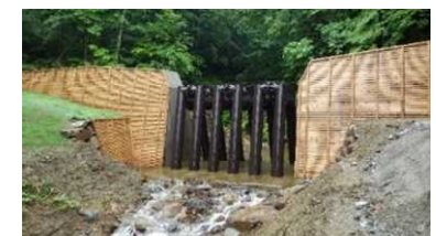
【治山：渓間工(雫石町)】
