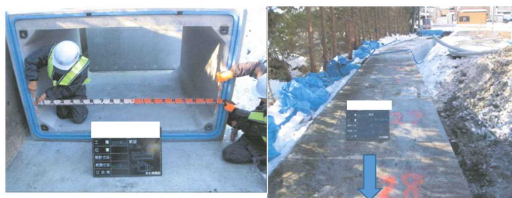
排水路の整備(1800×1100)
