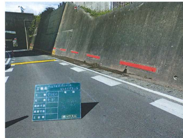
壁面浸水深表示
