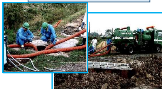
山の神都市下水路浚渫作業
