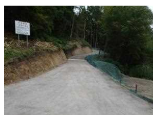
【森林整備: 林道開設(遠野市)】
