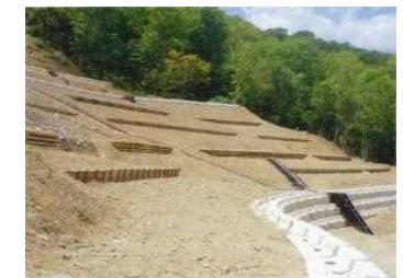
【治山：山腹工(雫石町)】
