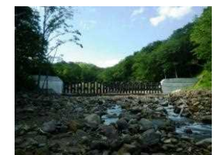
【治山: 渓間工(一関市)】
