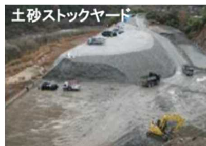
ストックヤード (土砂有効利用)
