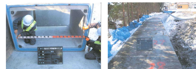
排水路の整備(1800×1100)
