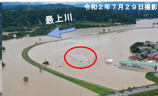
令和2年7月洪水により浸水した農業用ハウス
