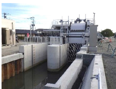
雨水ポンプ場の整備
