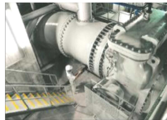
雨水ポンプの整備
