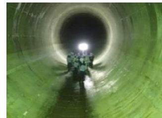
雨水貯留管の整備
