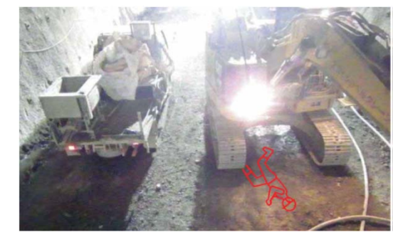
モルタル作業 整地作業
