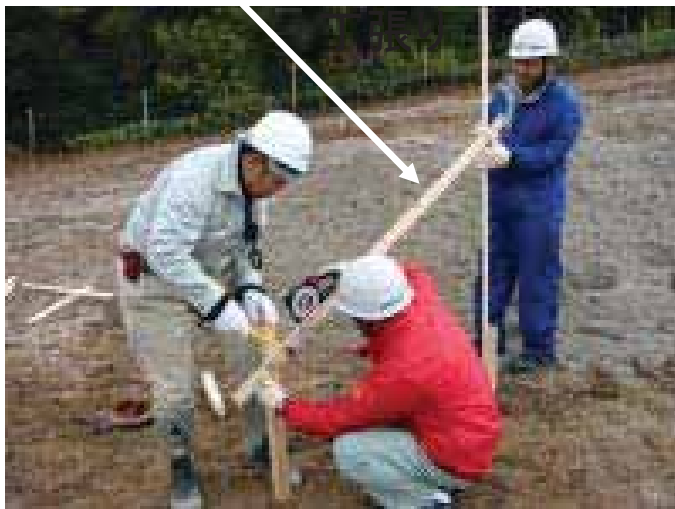
盛土作業前には、丁張り作業を実施
