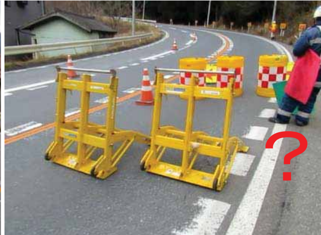
規制状況②（起点部後ろ側から）
