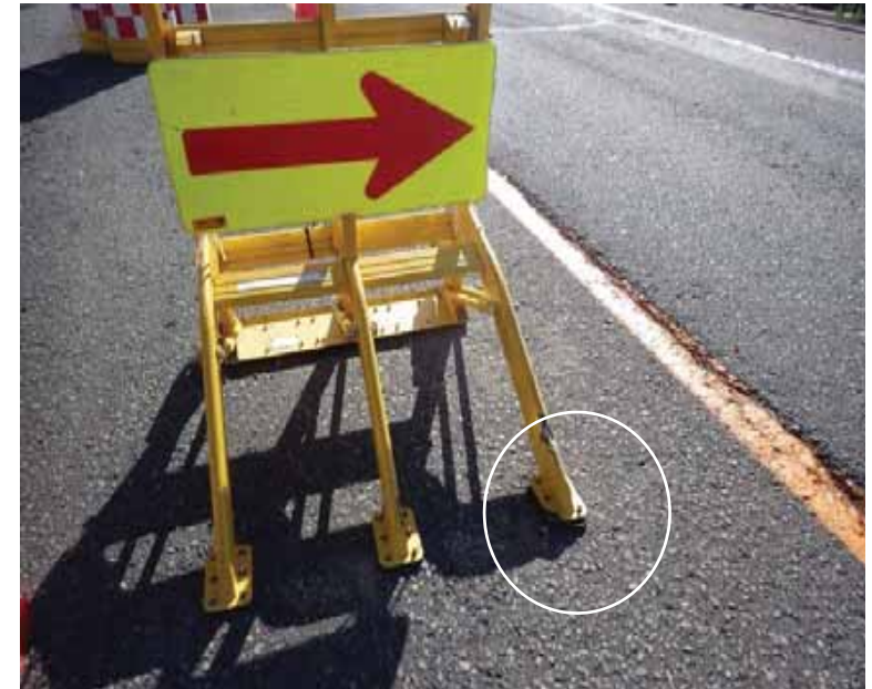
一般車両がぶつかり 保安施設が部分破損
