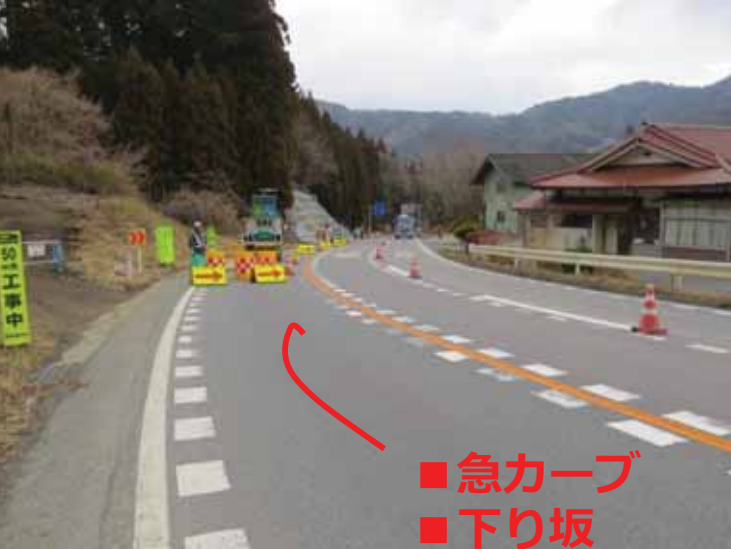
規制状況① (起点→終点)
