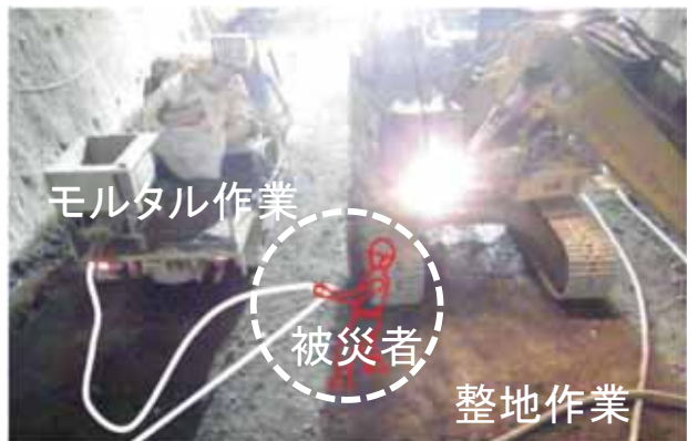
モルタル作業 整地作業
