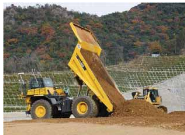
自動ダンプトラックと自動ブルドーザの連動作業
