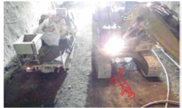
モルタル作業 整地作業
