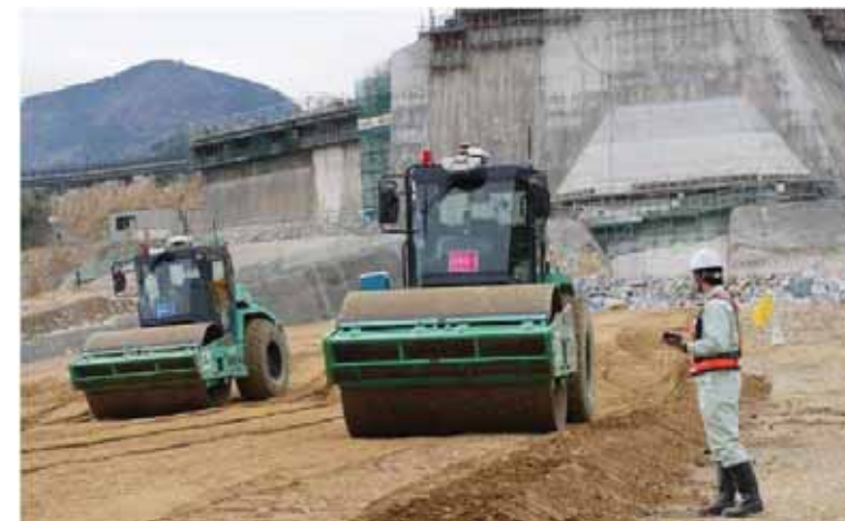
自動振動ローラでの転圧作業
