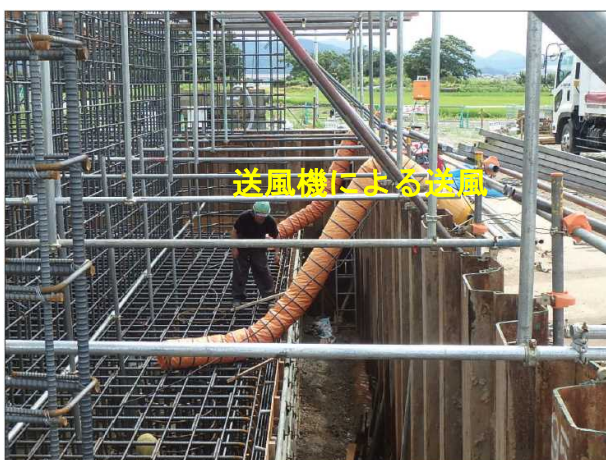
▲鋼矢板内の作業時における送風機の設置
