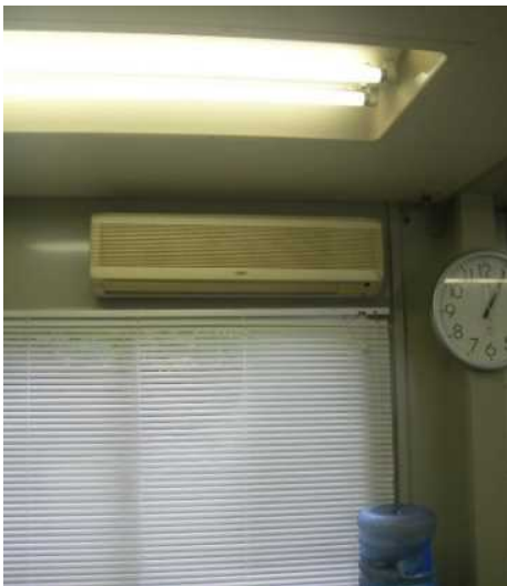
▲エアコン設置
