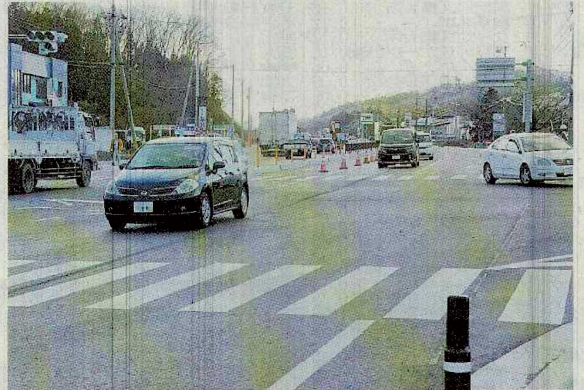
新たに4車線化された4号国道—白河市薄葉
