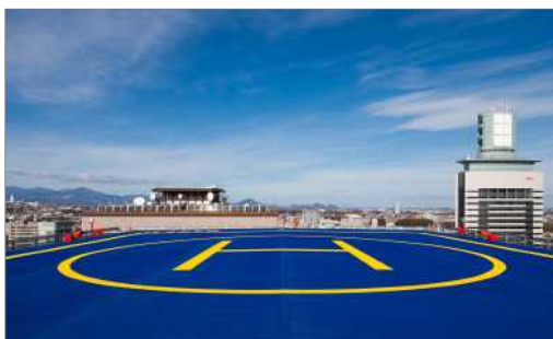
屋上ヘリポート
