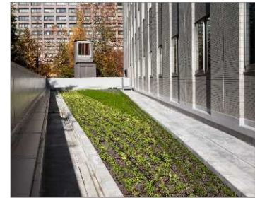
● 緑化のための対策 (屋上緑化)
