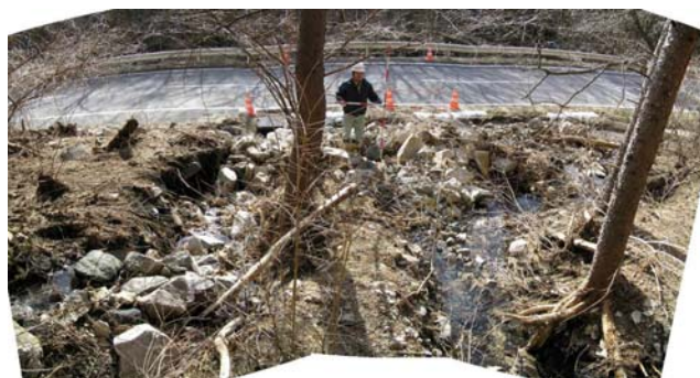
▼要対策箇所の状況(土石流堆積物)
