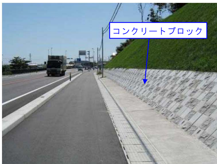
▼従来型「コンクリートブロック」施工イメージ
