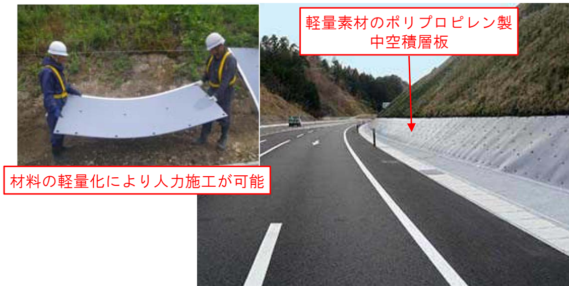
▼「軽量素材のポリプロピレン製中空積層板」施工イメージ（今後施工予定）
