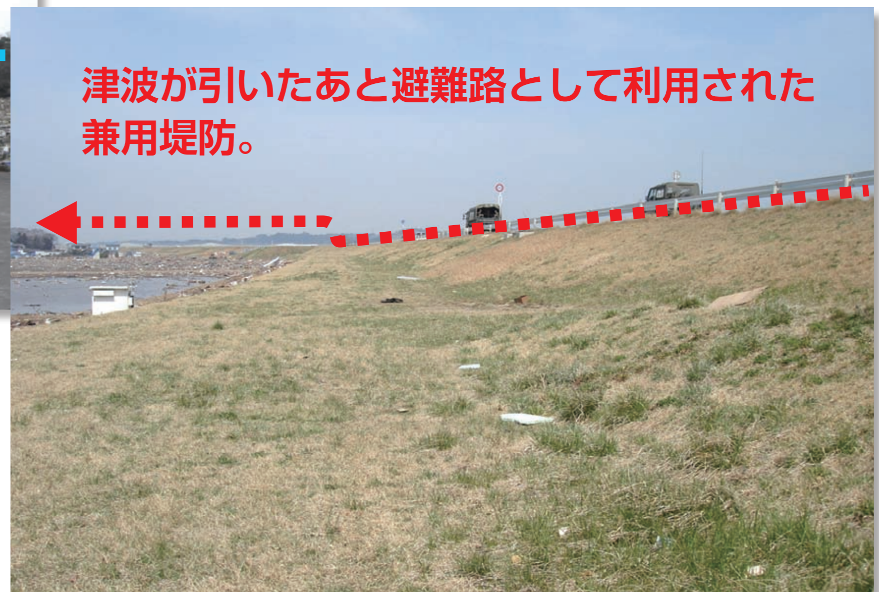
堤防は耐震対策されていたため、大きな被災無し
