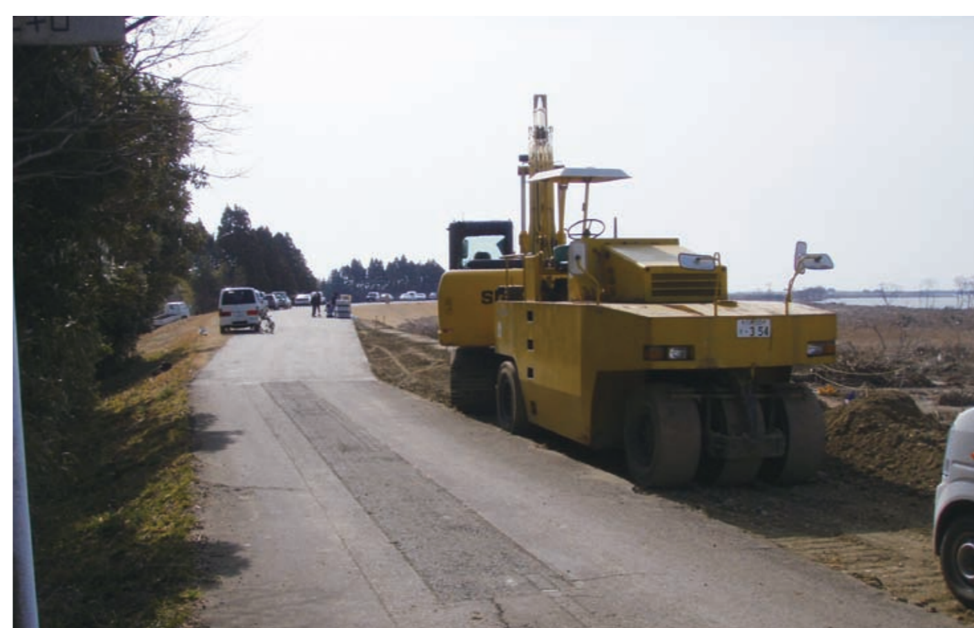
L4.1k 付近の堤防天端上に避難している重機・一般車両
