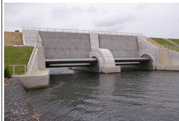
写真. 堤防との調和に配慮した水門の例① (旧北上川:鴉波水門)
