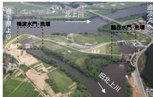
旧北上川への洪水時の流量を低減する分流施設 (2007年完成)
