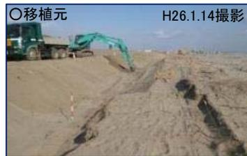
海浜植物種子・地下茎等が含まれる砂地盤表面部を掘削・運搬
