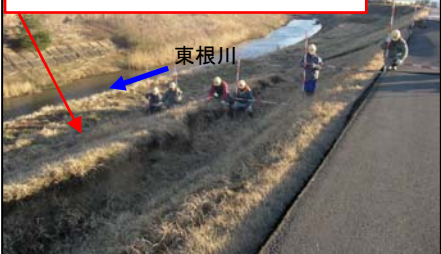
堤内地側(東根川)の法面に現れた滑りによる隆起
