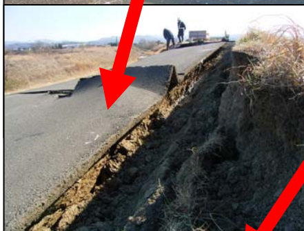
堤内地側(東根川)の法面に現れた滑りによる隆起
