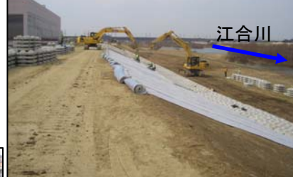
大型連節ブロック張りの施工状況
