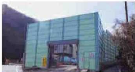
防音壁 遮音効果12dB(A)～18dB(A)
