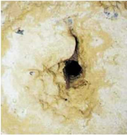
NJD工法による穿孔後状況
