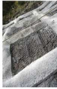
勾配緩和網設置完了
