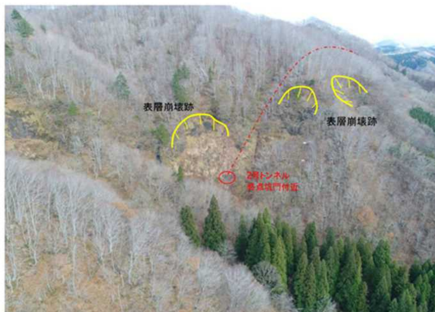
写真 2.1.3 2号トンネル終点側上空より見る
