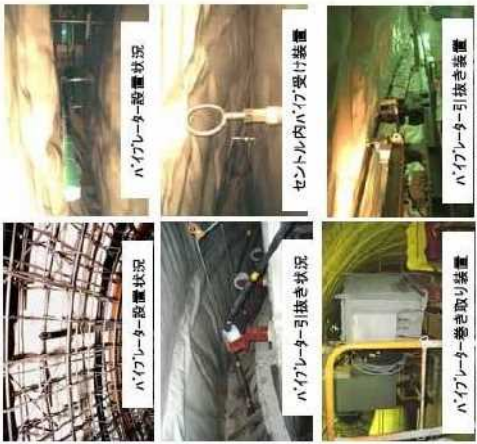
主に鉄筋コンクリート覆工用 天端パイプレータ 天端パイプレータ設置引抜き状況(鉄筋、無筋用)
