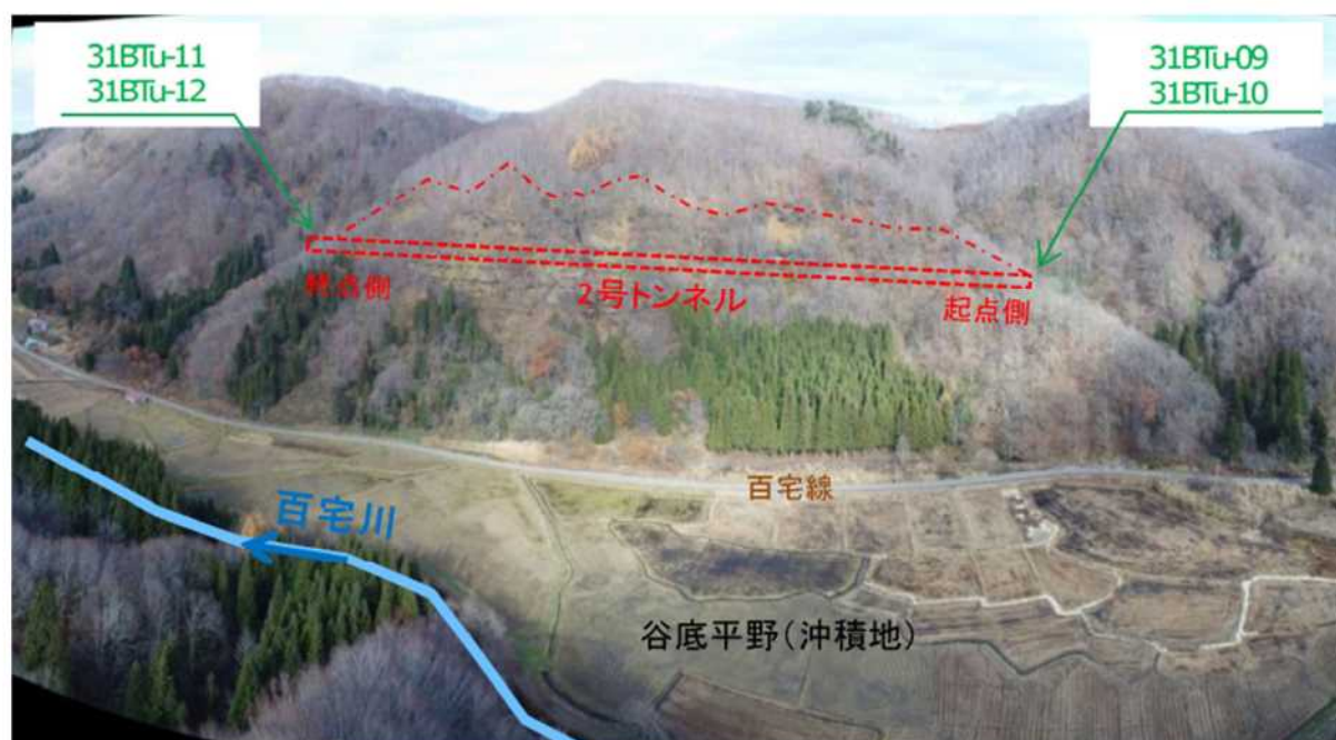
写真 2.1.1 2号トンネル計画箇所 斜め上上空より見る
