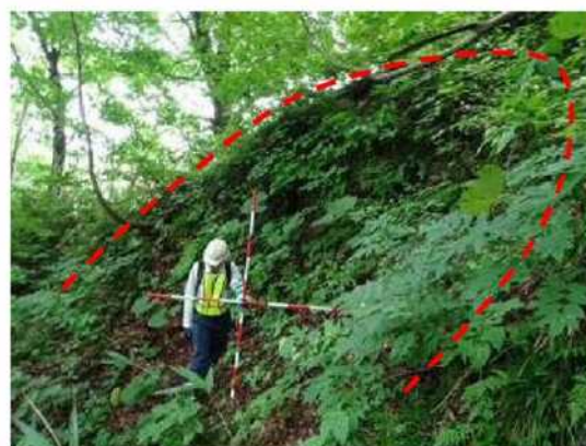
写真 12.10.1 弧状の急崖に囲まれた崩落跡 (地質調査※1 中間報告書より)
