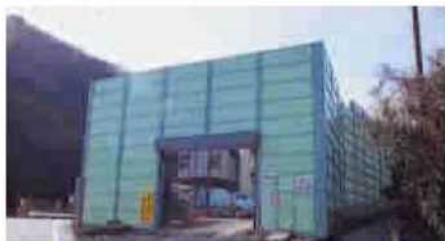
防音壁 遮音効果12dB(A)～18dB(A)
