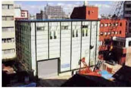
Ⅲ・Ⅳ・Ⅴ型防音ハウス 遮音効果25dB(A)～40dB(A)
