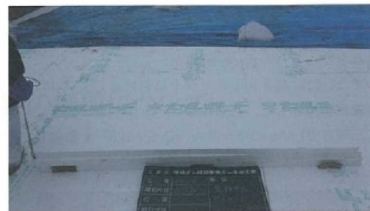
写真-6.4 断熱材 (t=40mm)
