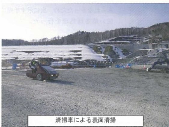
写真-8.3 CSG 越冬面の処理状況
