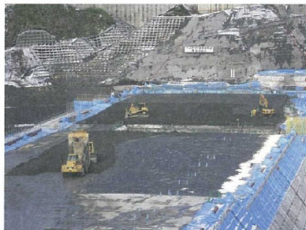
写真-8.2 CSG 越冬リフトの養生状況 (覆土)
