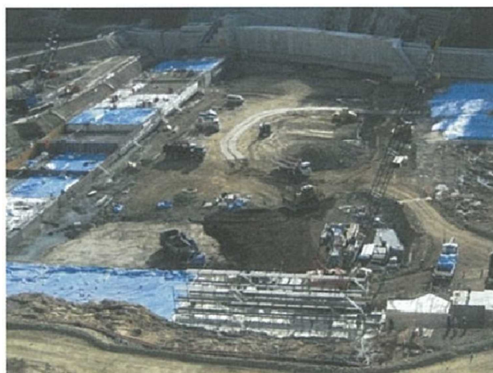
写真 1.3 サンルダム CSG の覆土状況
