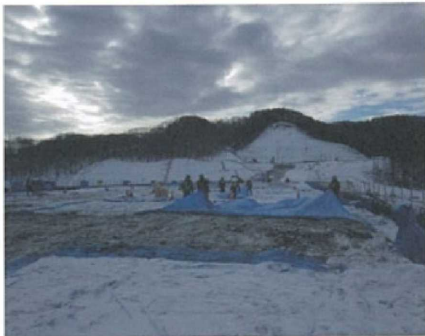
① 保温マット・ブルーシート撤去
