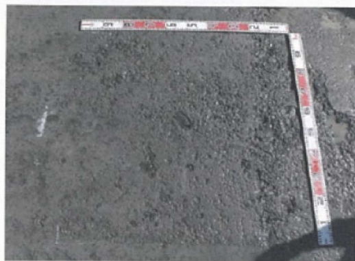
写真-6.6 越冬面処理後の CSG 表面の状況
