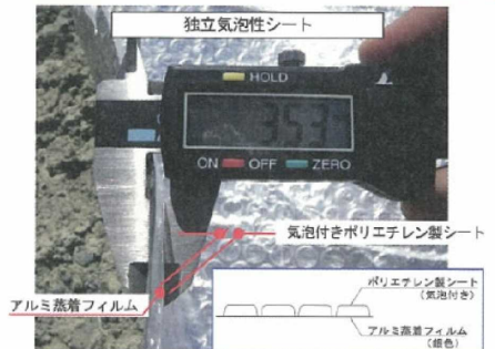
写真 1.1 当別ダム 養生状況・養生シート
