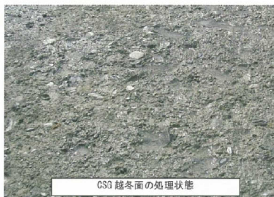
写真-8.3 CSG 越冬面の処理状況
