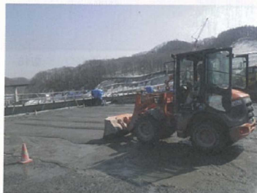
写真-6.7 CSG 越冬面モルタル敷設状況
