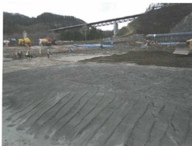
写真-4.31 モルタルによる CSG 越冬面の打継処理状況
