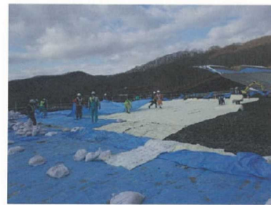
保温マット、ブルーシート敷設状況
