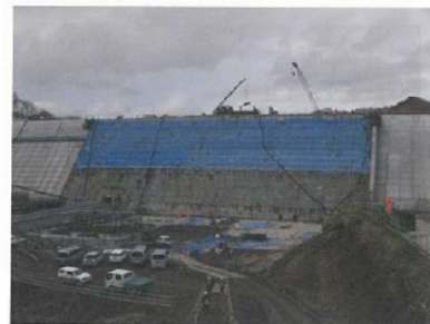
常用洪水吐越冬養生完了全景
