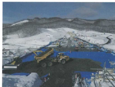
CSG 越冬面の覆土実施状況
