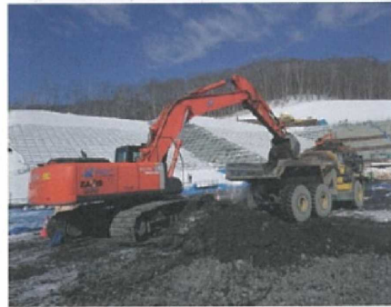
② CSG 材覆土撤去
