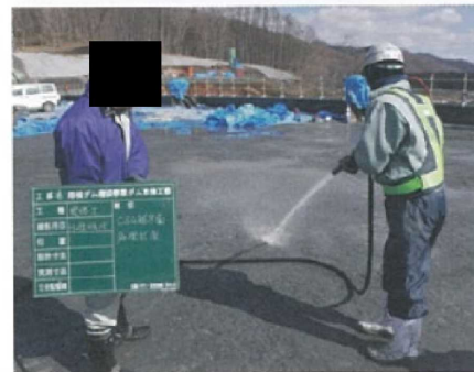
③ CSG 表面の浮石・付着物除去
