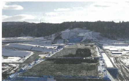
写真-8.1 堤体越冬リフトの養生状況全景
