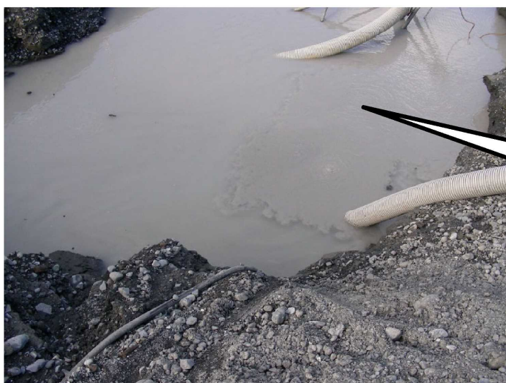
写真 1.1.1 鳥海ダムと同様河床砂礫を母材としたダムの基礎掘削状況
