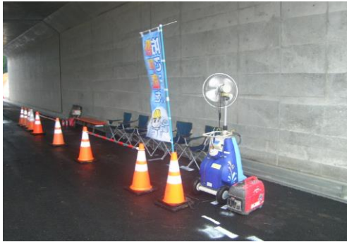
扇風機用発電機が熱をもって発火するかもしれない。
