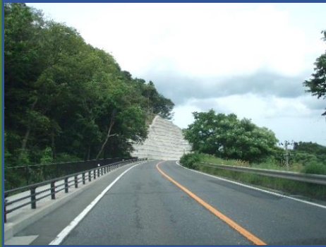
国道104号南部町 八木田跨線橋
