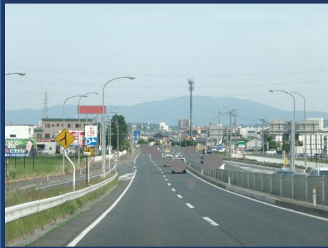
国道45号北バイパス 河原木交差点の合流部
