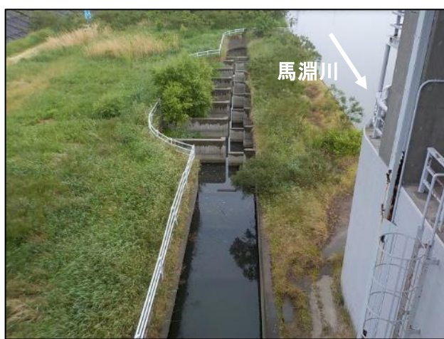
右岸魚道 【土砂撤去前】
