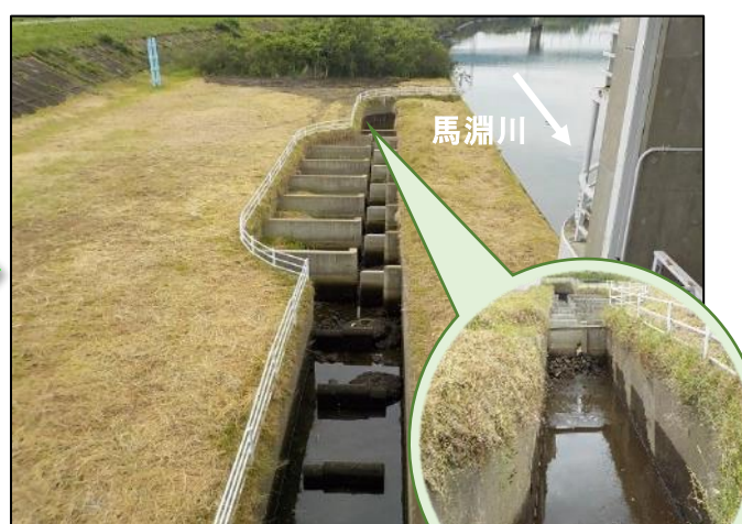
右岸魚道 【土砂撤去後】
