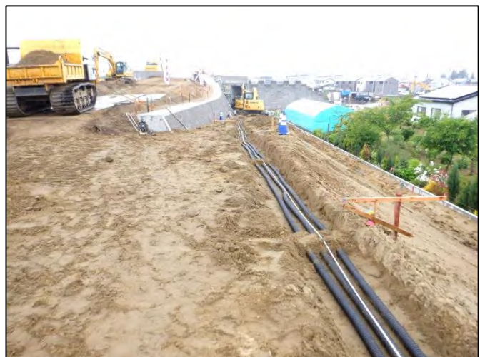
光ケーブル配管工
