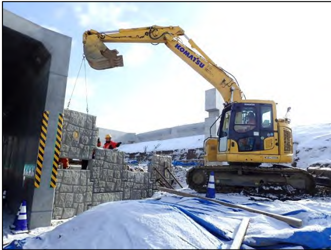
補強土壁工
