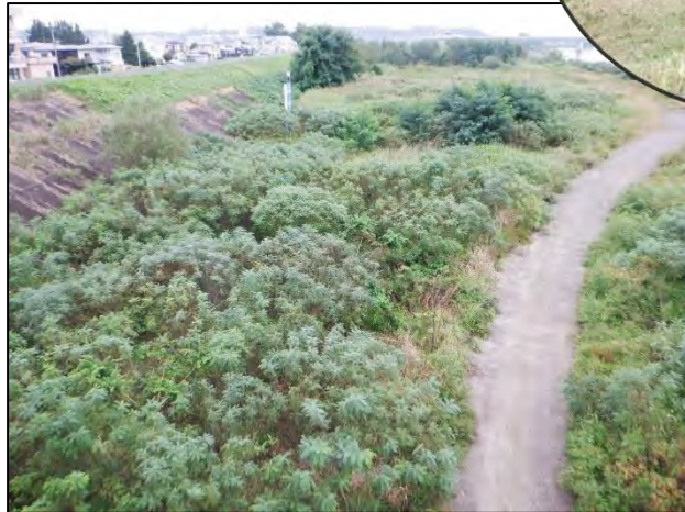
馬淵大堰下流【除草】前
