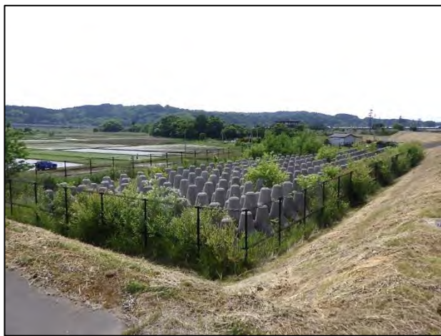
馬淵川防災ステーション資材置き場【除草】前
