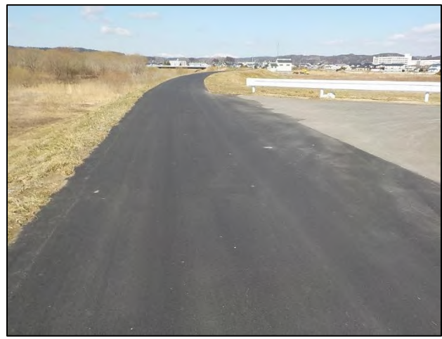
堤防天端舗装(浅水川付近)【打換え】後
