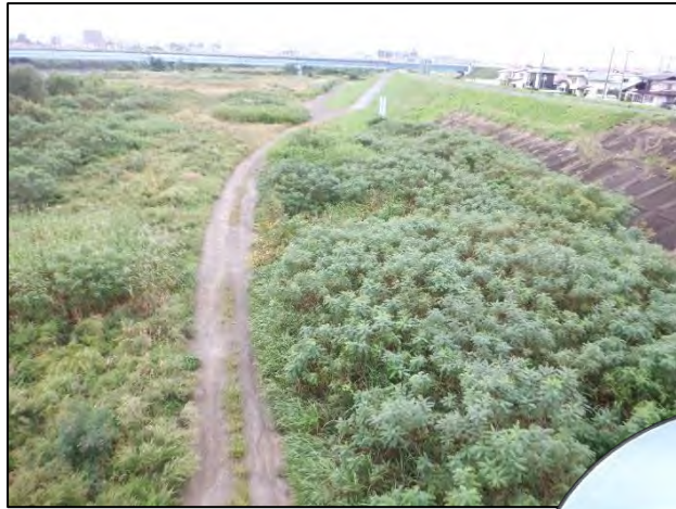
馬淵大堰上流【除草】前
