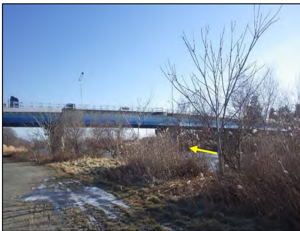
大橋上流(左岸)【樹木伐採】前
