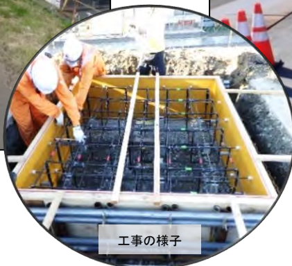
空中線柱基礎【工事】前
