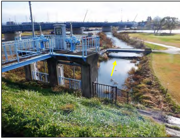
古川排水樋管堤外水路【樹木伐採】前
