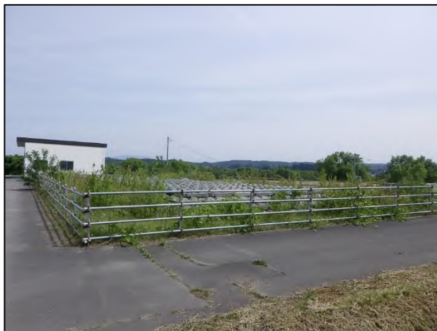
馬淵川防災ステーション資材置き場【除草】前
