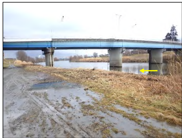
大橋上流(左岸)【樹木伐採】後
