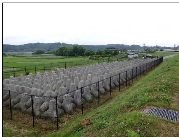
馬淵川防災ステーション資材置き場【除草】後
