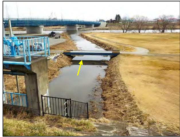
古川排水樋管堤外水路【樹木伐採】後
