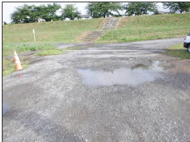
右岸3.6k【補修】前
