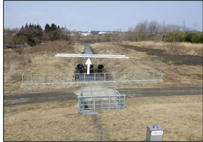
堤外水路【土砂撤去】後
