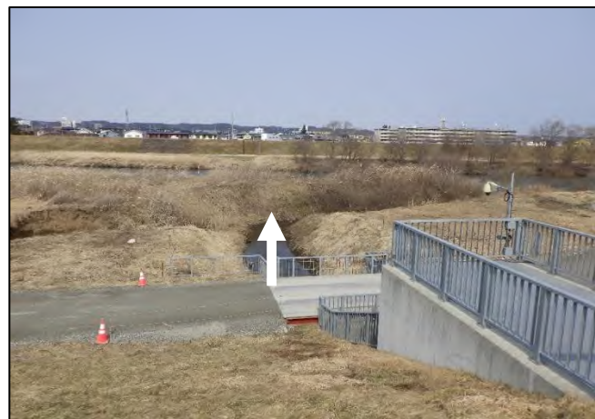
堤外水路【土砂撤去】後
