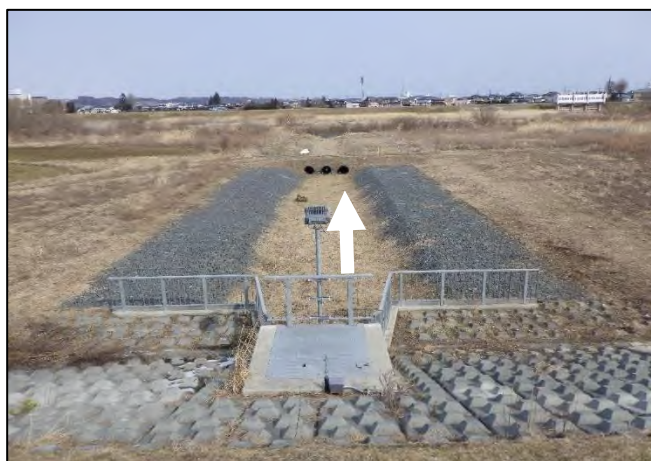
堤外水路【土砂撤去】後
