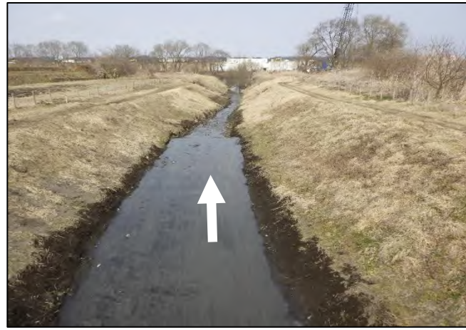
堤外水路【土砂撤去】後
