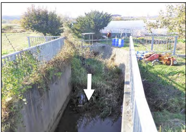
堤内水路【土砂撤去】前
