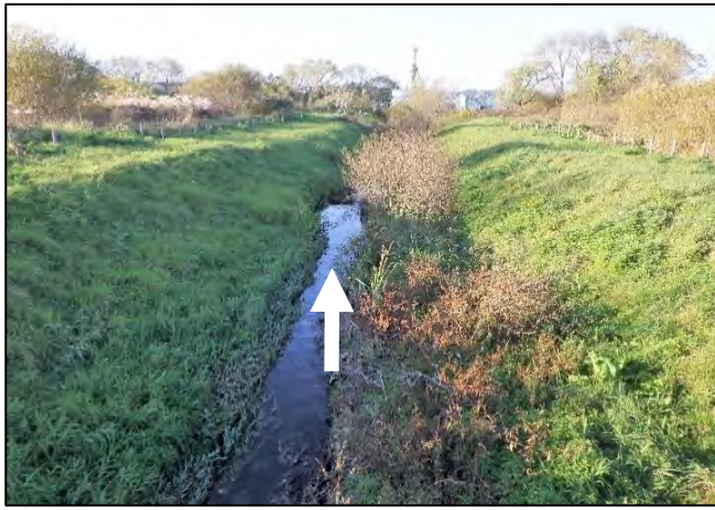
堤外水路【土砂撤去】前
