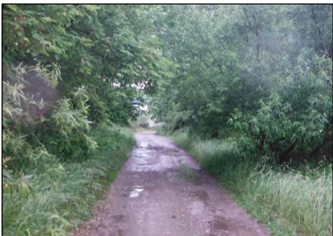
大橋上流右岸管理用道路【樹木伐採】前
