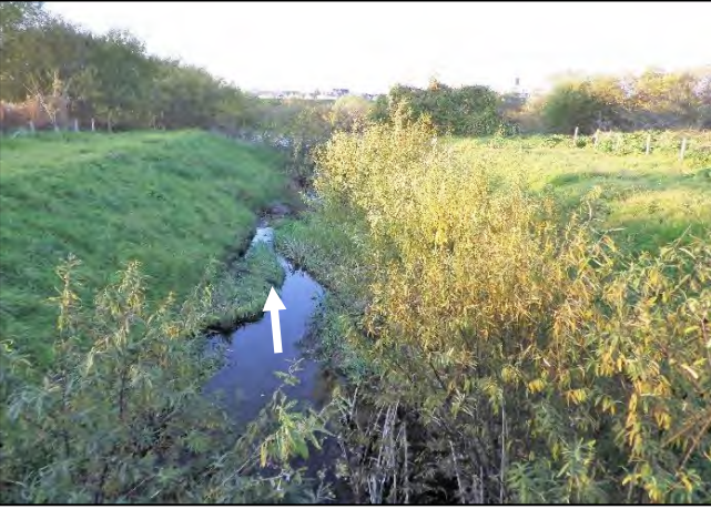
堤外水路【土砂撤去】前
