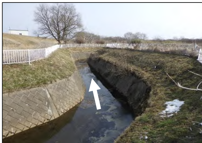
堤外水路【土砂撤去】後
