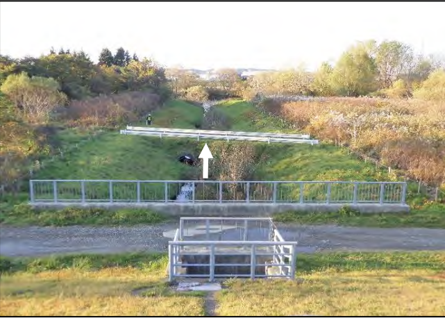
堤外水路【土砂撤去】前
