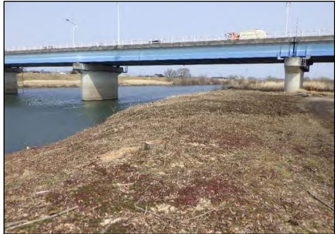
大橋上流右岸側【樹木伐採】後
