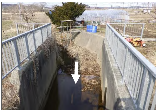
堤内水路【土砂撤去】後
