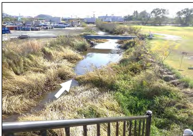
堤外水路【土砂撤去】前
