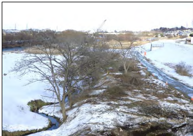
尻内橋下流の【樹木伐採】前
