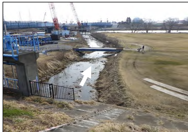
堤外水路【土砂撤去】後
