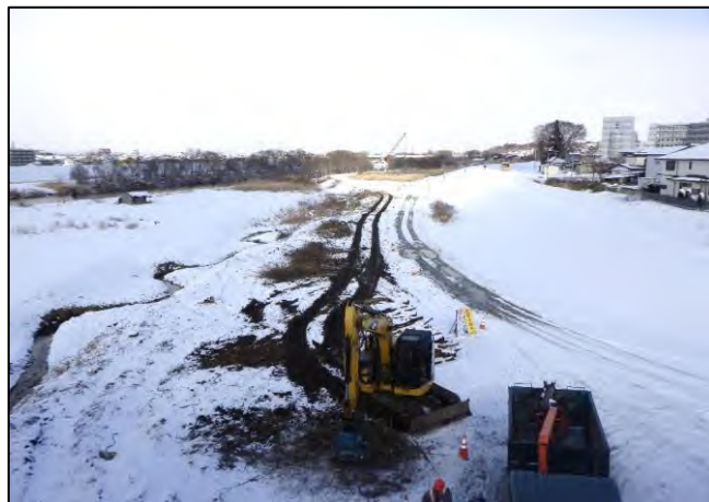
尻内橋下流の【樹木伐採】後
