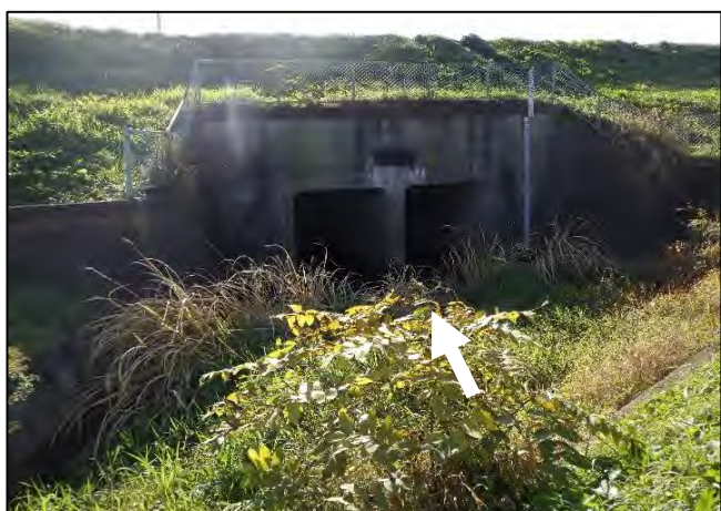
堤内水路【土砂撤去】前
