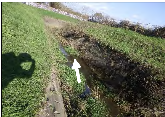
堤外水路【土砂撤去】前
