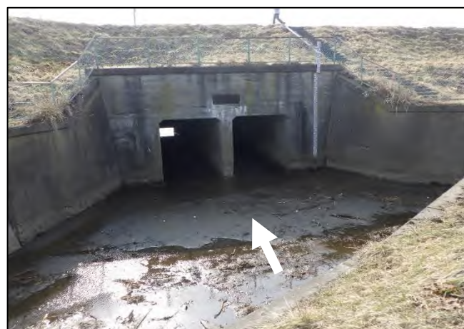
堤内水路【土砂撤去】後
