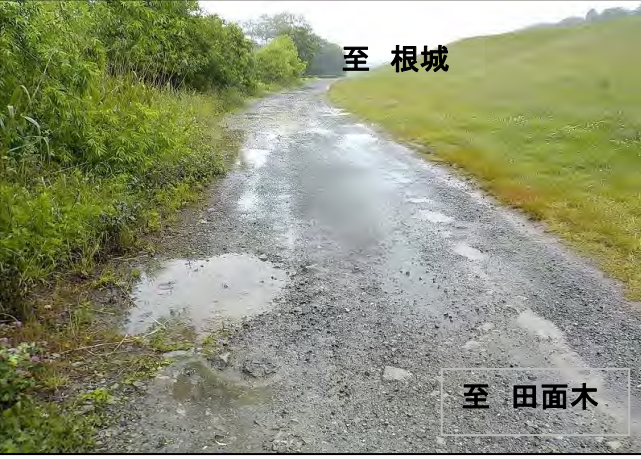
根城地区(右岸)【樹木伐採】前
