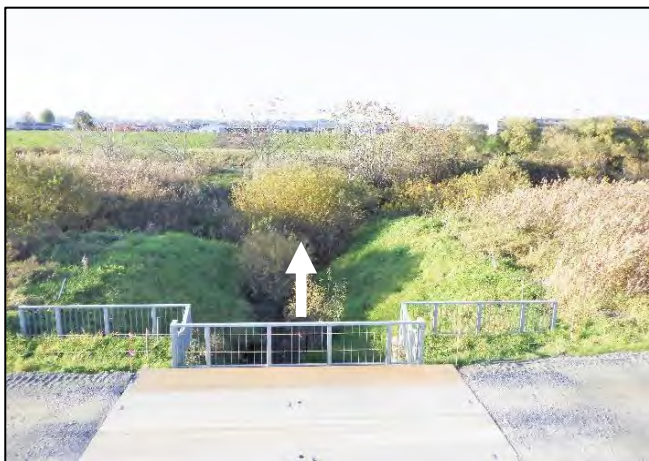
堤外水路【土砂撤去】前
