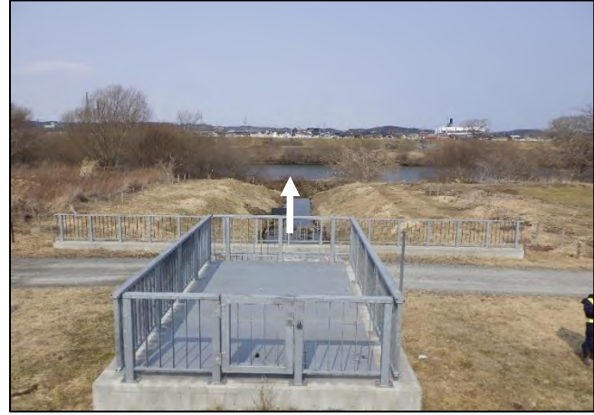
堤外水路【土砂撤去】後
