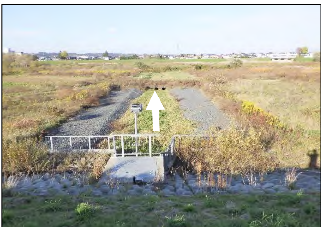
堤外水路【土砂撤去】前
