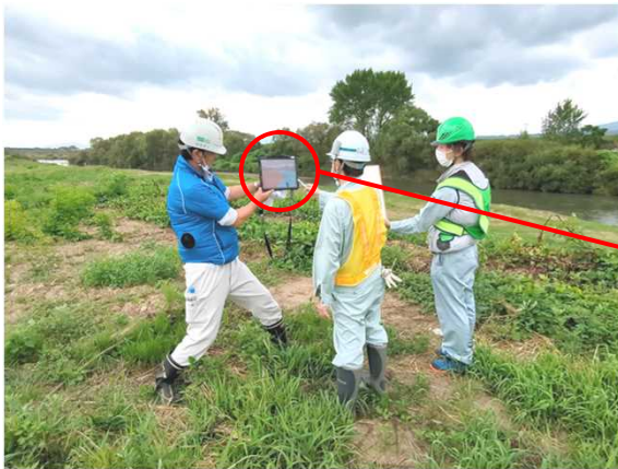
法線確認状況
