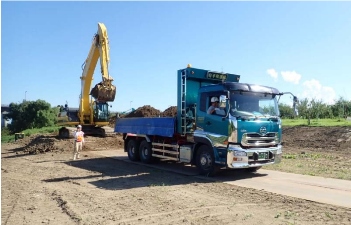
2018.8.23 掘削土積み込み作業
