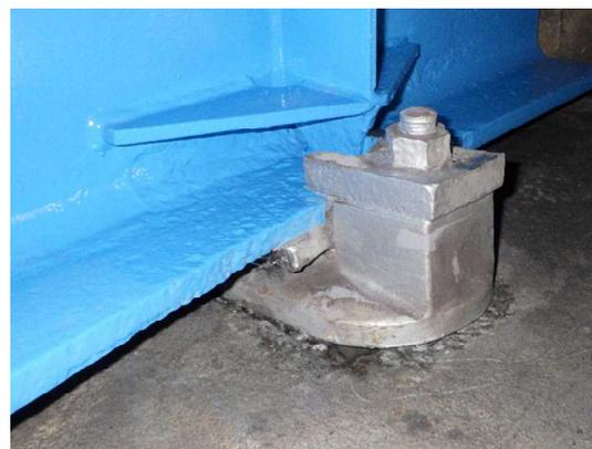
写真4-12 【対策】支承防錆（金属溶射）
