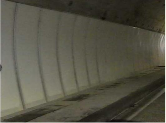
写真4-18 【対策】面導水施工
