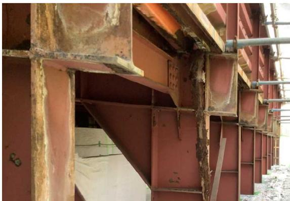
写真 4-20 【損傷】鋼部材の腐食
