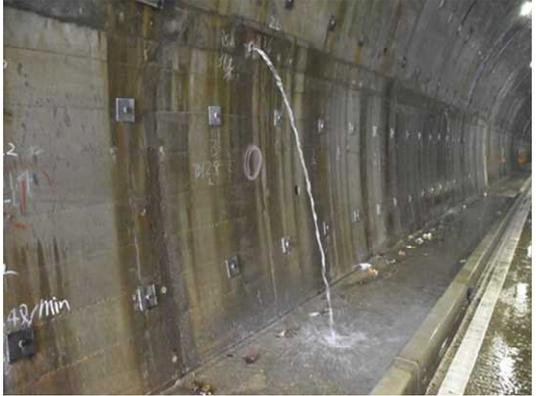
写真4-17 【損傷】漏水
