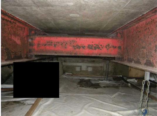
写真4-14 【損傷】主桁の腐食
