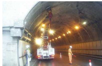
写真2-2 トンネル点検状況
