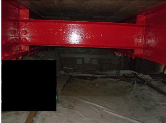
写真4-15 【対策】主桁の補修・塗替え
