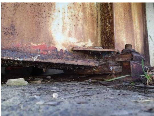
写真4-11 【損傷】支承の腐食
