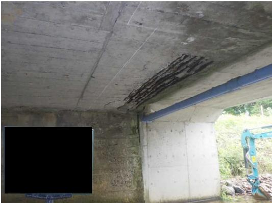
写真4-2 【損傷】鉄筋露出
