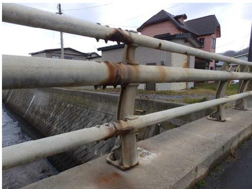
写真4-5 【損傷】防護柵の腐食欠損
