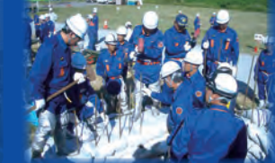
水防工法訓練(月の輪工)
