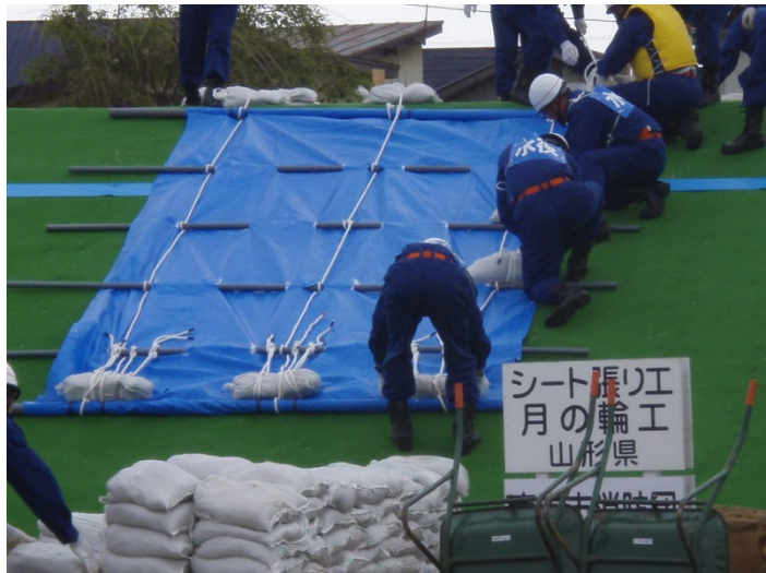
▲シート張り工法訓練の様子
