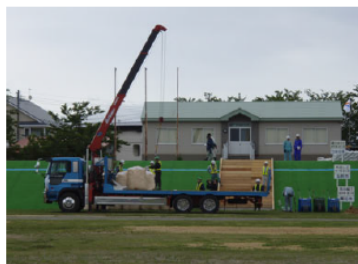
▲大型土のう積みの様子
