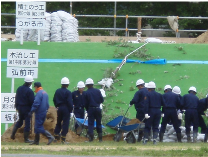
▲木流し工法訓練の様子
