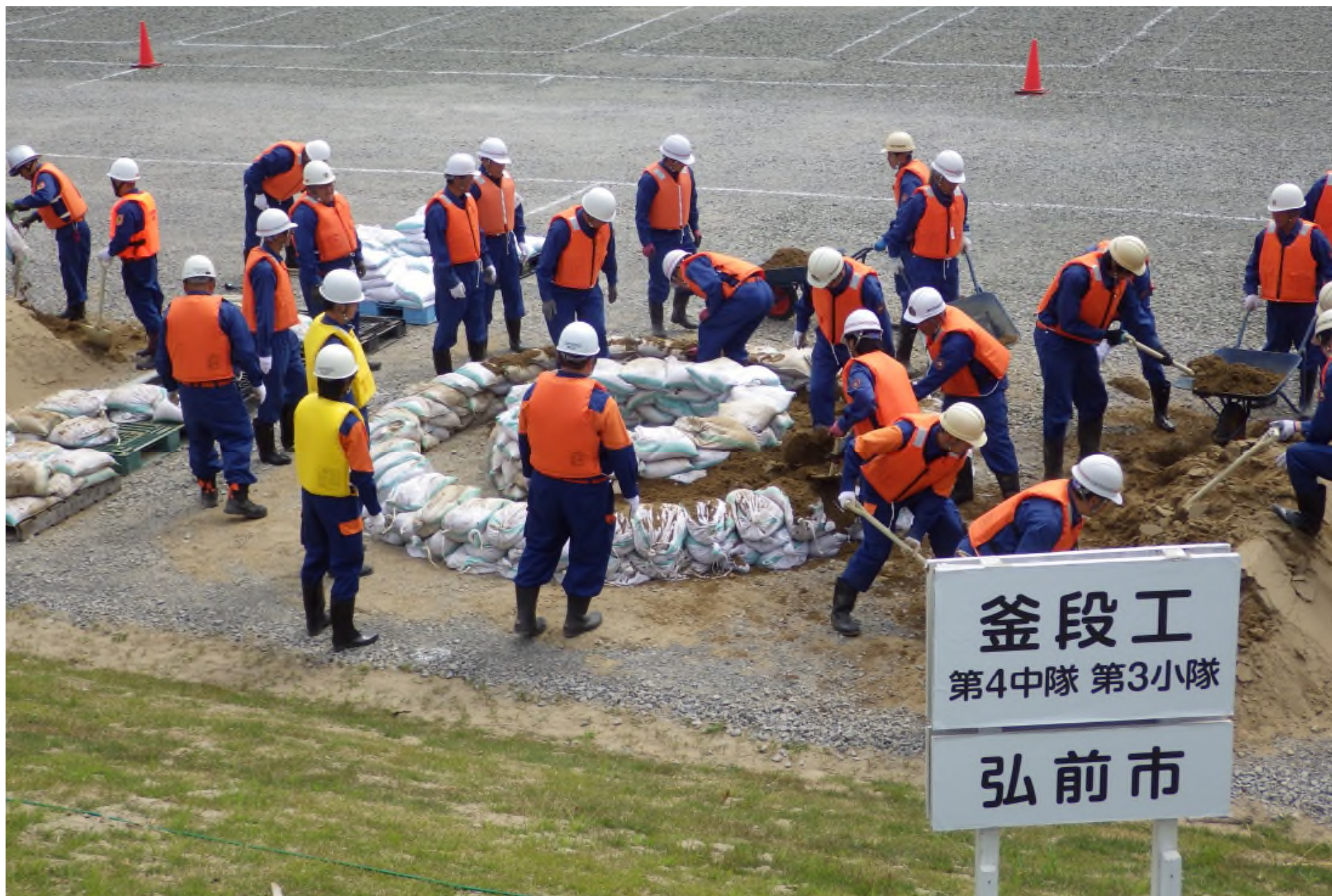
＜訓練状況＞水防工法 釜段工
