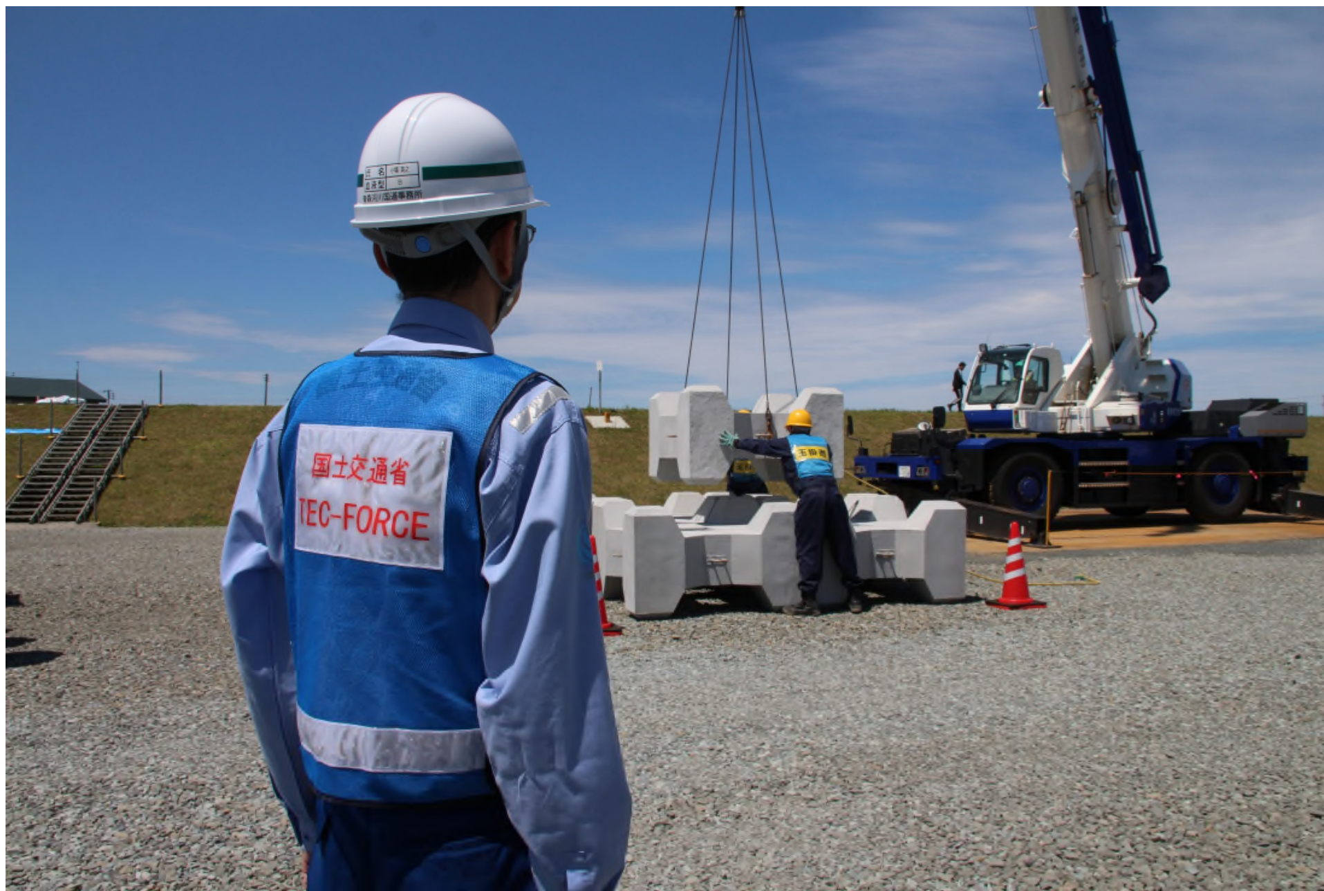
＜訓練状況＞ 応急復旧訓練 全国土木コンクリートブロック協会・青森県建設業協会
