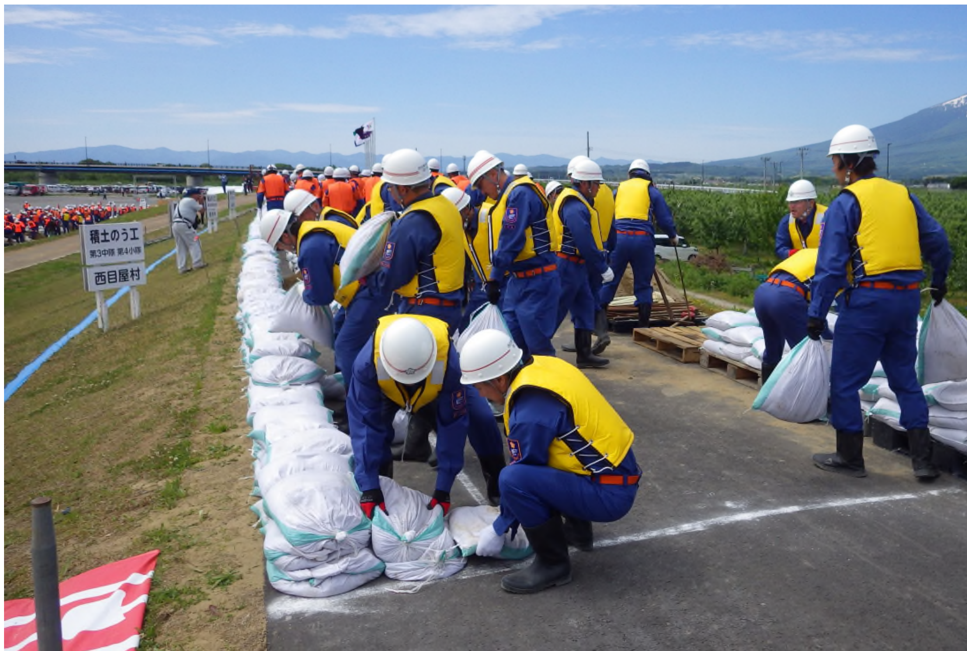
＜訓練状況＞水防工法 積土のう工
