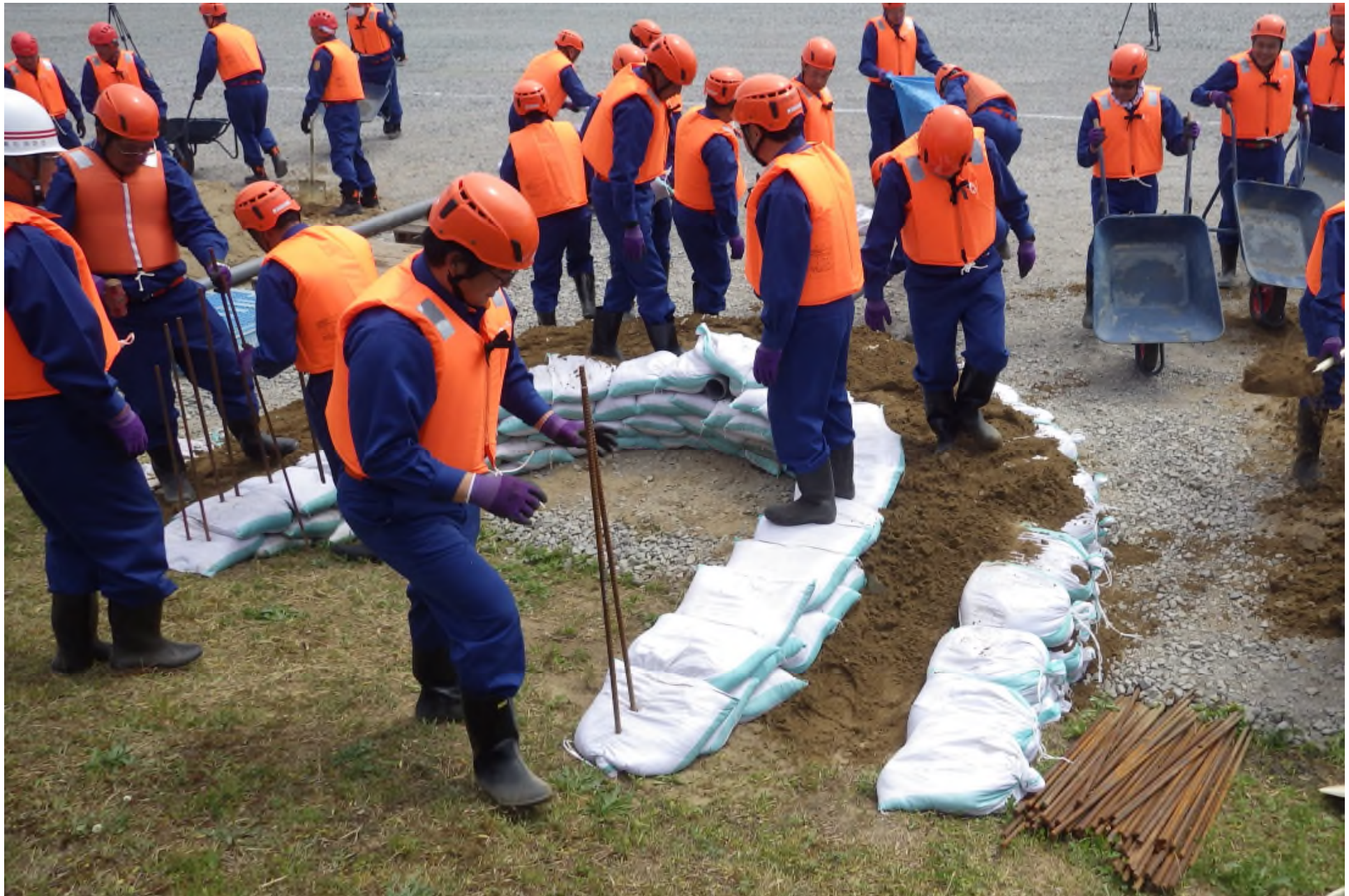
＜訓練状況＞水防工法 月の輪工
