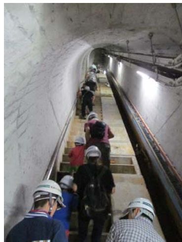
ダム湖ふれあいデー(堤体内見学)
