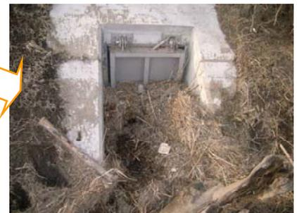
予備ゲート整備による津波逆流被害防止の状況（浜名谷地排水樋管）
