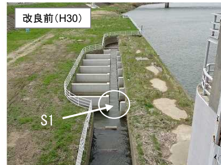
■右岸魚道の改良(R1年度)前後の状況 (大堰ゲート全開時)
