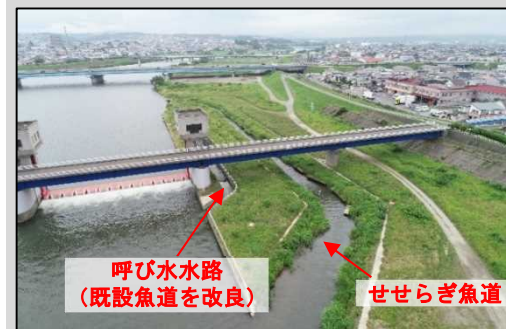
左岸魚道 (整備完了)
