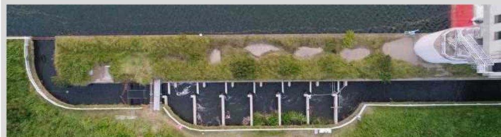
右岸パーティカルスロット式魚道 (R4.6撮影)
