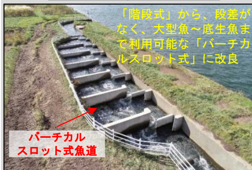
右岸魚道 (整備完了)
