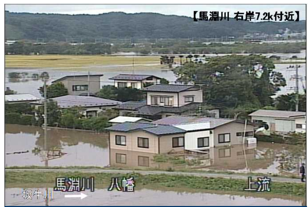
平成23年9月洪水 八戸市八幡地区の冠水状況
