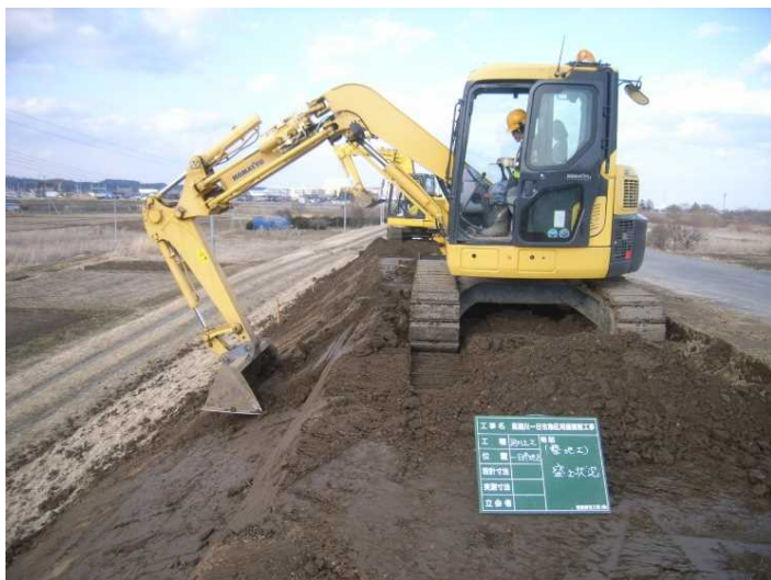
掘削土砂を側帯盛土として利用
