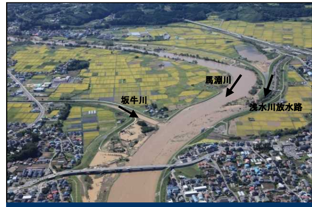
平成25年9月洪水 支川浅水川(尻内町)周辺の冠水状況
