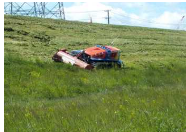
堤防除草作業の無人化
