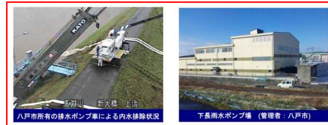
八戸市所有の排水ポンプ車による内水排除状況
