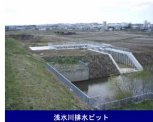
浅水川排水ピット
