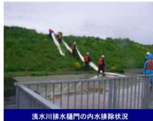
浅水川排水樋門の内水排除状況
