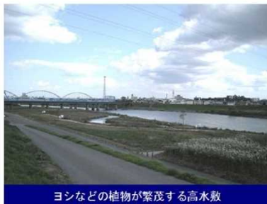
ヨシなどの植物が繁茂する高水敷
