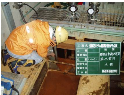
ダム堤体の漏水量の調査
