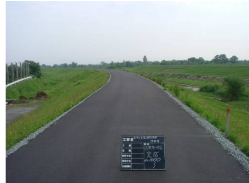
舗装後の状況
