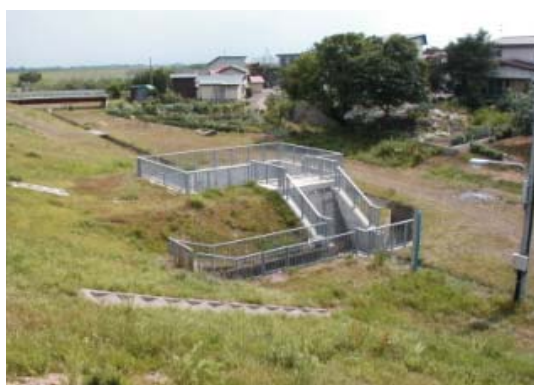
弘前市鳴瀬地区排水ピット
