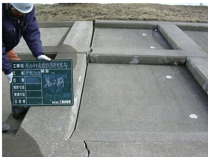
護岸の損傷
