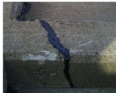
護岸の補修状況
