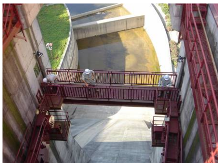
放流設備の点検
