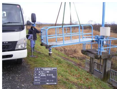
老朽化した管理橋の更新
