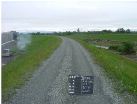
舗装前の状況
