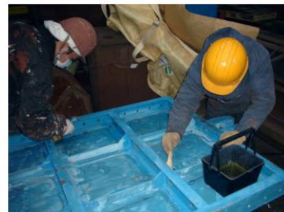
ゲートの補修
