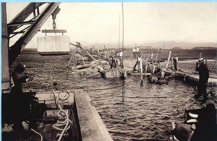
南突堤工事 (昭和8年8月4日撮影)
