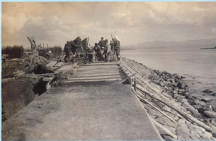
北突堤工事中 (昭和6年10月24日撮影)
