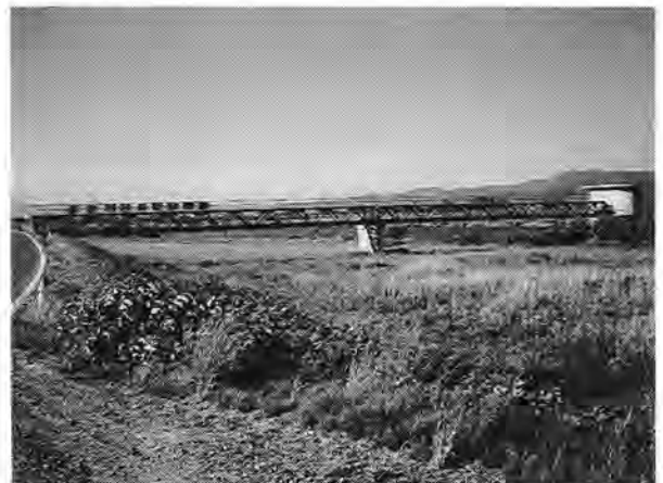
稲垣村上水道取水施設（岩木川左岸）
