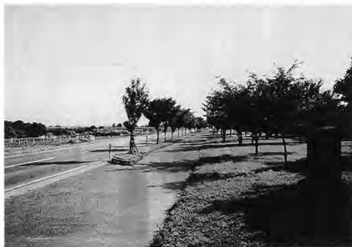
治水の向上と河川の環境を地域の人と一緒に整備した「桜づつみモデル事業」(岩木川弘前地区右岸)
