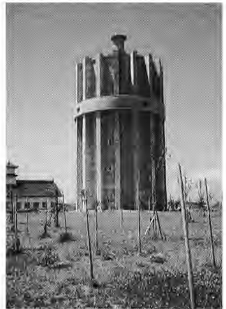
高架配水塔（最高地上57.16m、内径23m） 津軽広域水道企業団（浅瀬石川ダムより取水） からの受水により安定した給水を行っている
