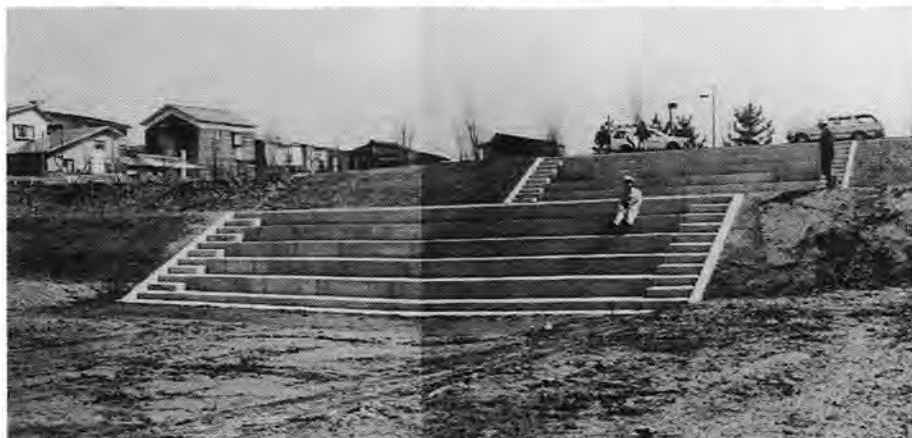
河川環境整備事業（岩木川鶴田地区右岸の階段工）
